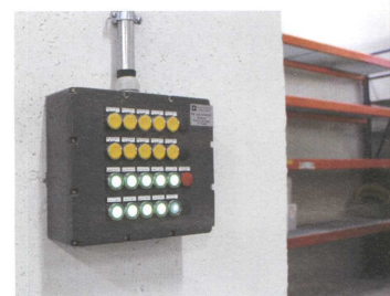
La pulsantiera delle luci di comando (pulsanti dal diametro di 22 mm), presente su ogni piano, può essere utilizzata anche da persone che portano quanti
