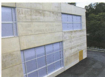
La facciata Nord dell'azienda, protetta da telecamere e barriere interne
